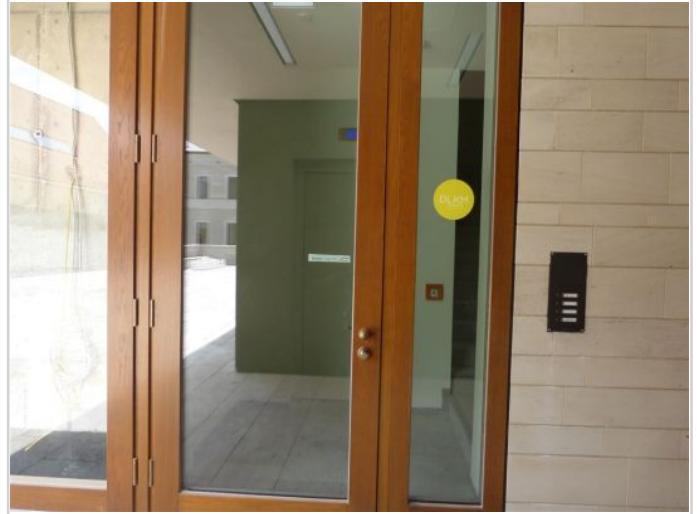
Haupteingang mit Aufzug
